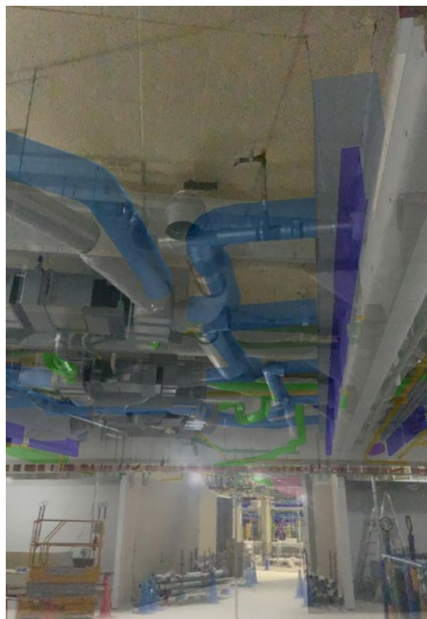
現場でのAR空間 (現実区間と施工図BIMとの合成)(モデル現場にて)
