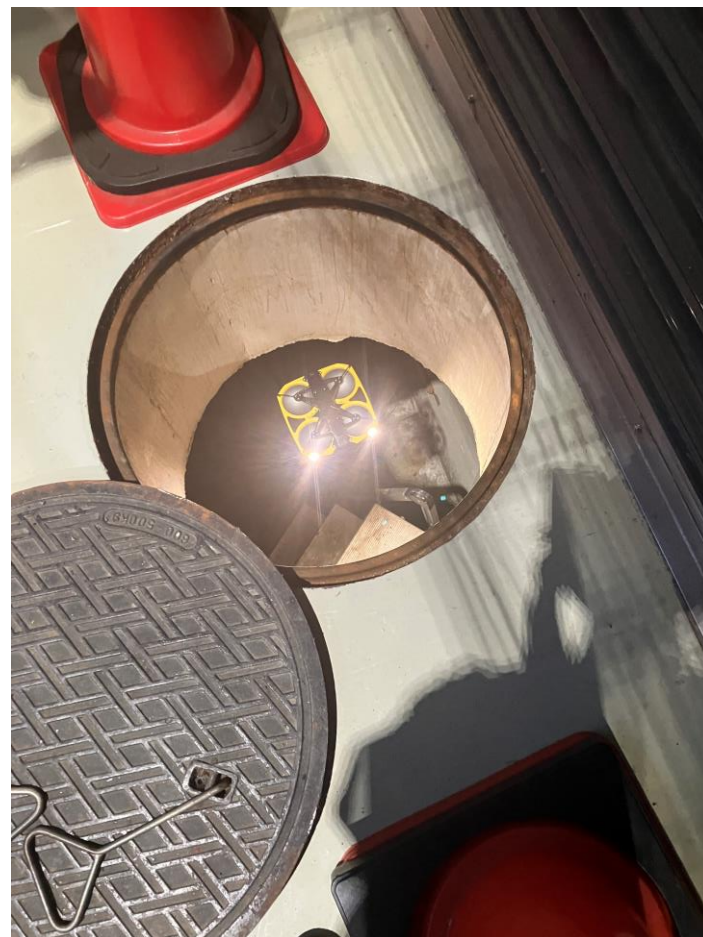
ピット内調査（進入）
