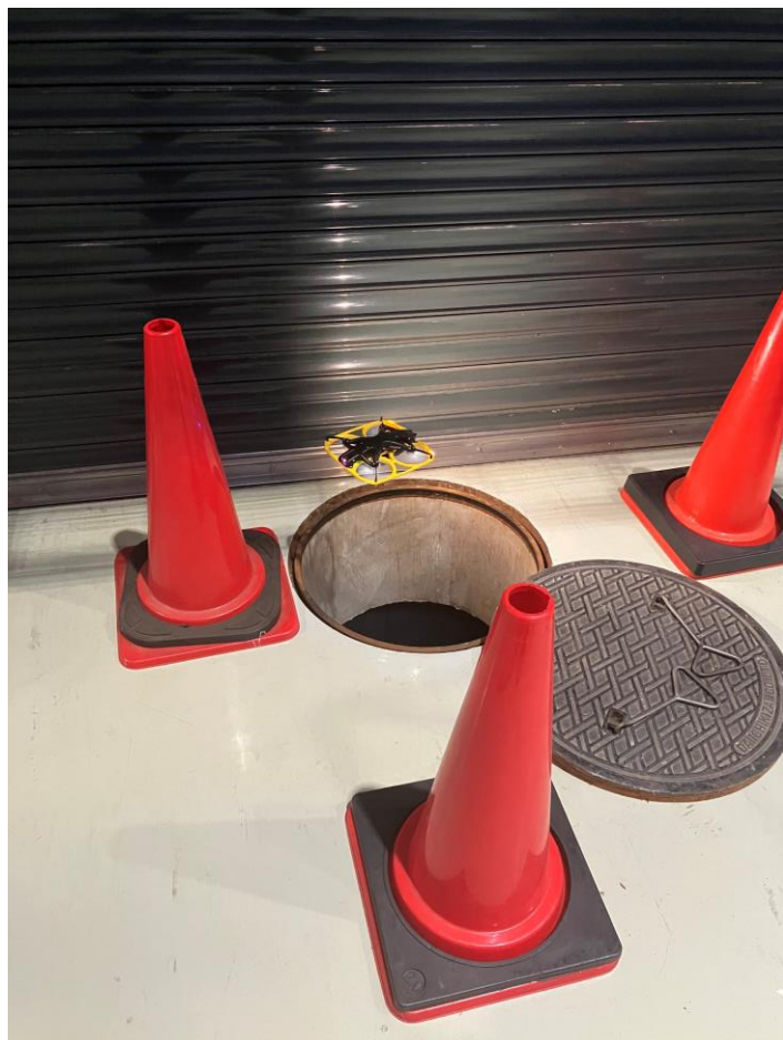
ピット内調査（進入）
